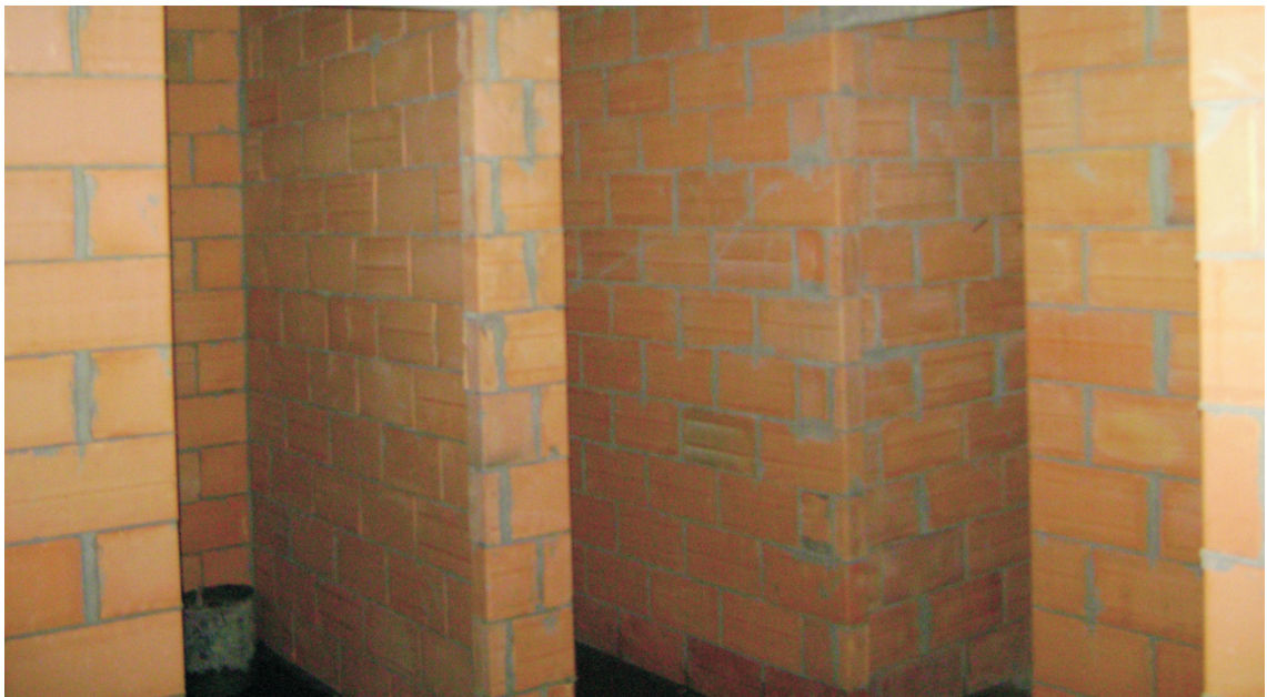
Figura 1 - Alvenaria de vedação em blocos cerâmicos
