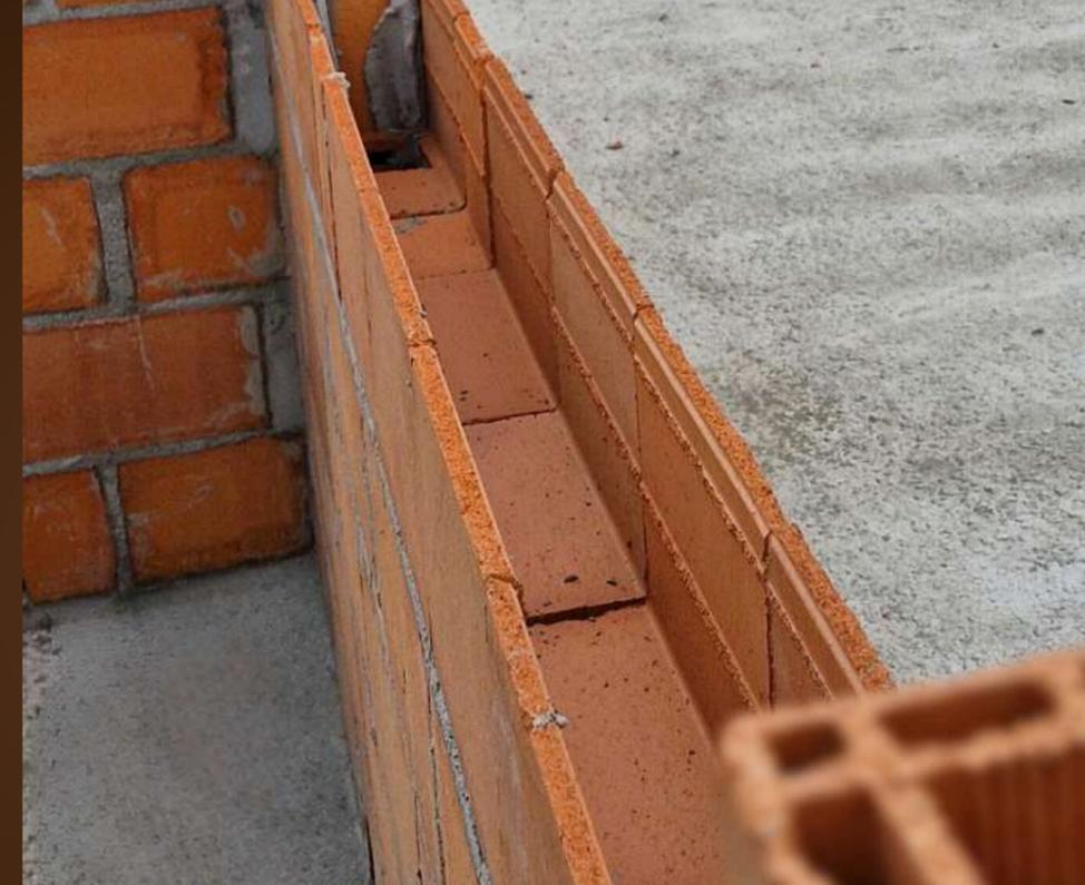
As canaletas são blocos complementares utilizados na construção de vergas e contravergas de portas e janelas, além de serem empregados nas vigas de respaldo ou vigas de suporte das lajes. Inicialmente usadas como forma, após a concretagem passam a fazer parte integrante da estrutura da edificação.
