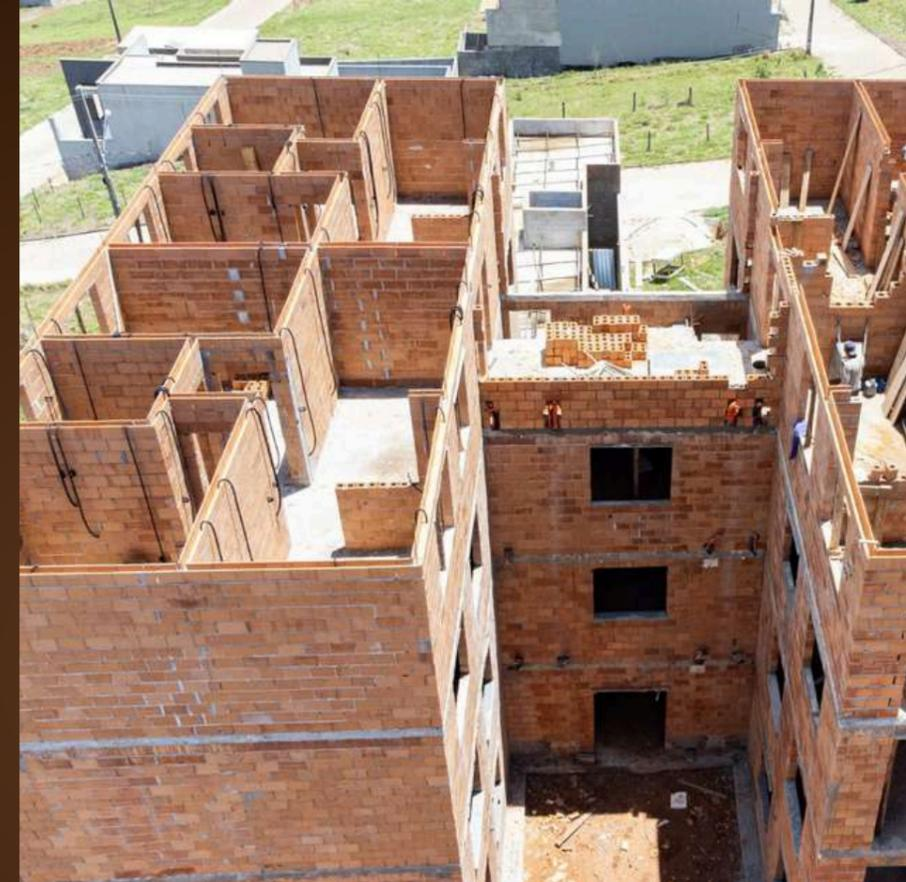
Os blocos cerâmicos de vedação são utilizados em sistemas construtivos que não exercem função estrutural, sendo ideais para fechar paredes que contam com vigas e pilares de sustentação, dividir espaços e embutir tubulações ou conduítes, podem ser cortados sem comprometer a estrutura, possibilitando ajustes e personalizações.
